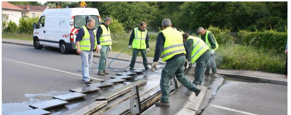
■ Mise en place d'un batardeau : l'une des actions à mettre en place pour se préserver de l'inondation du Garon à Givors.
